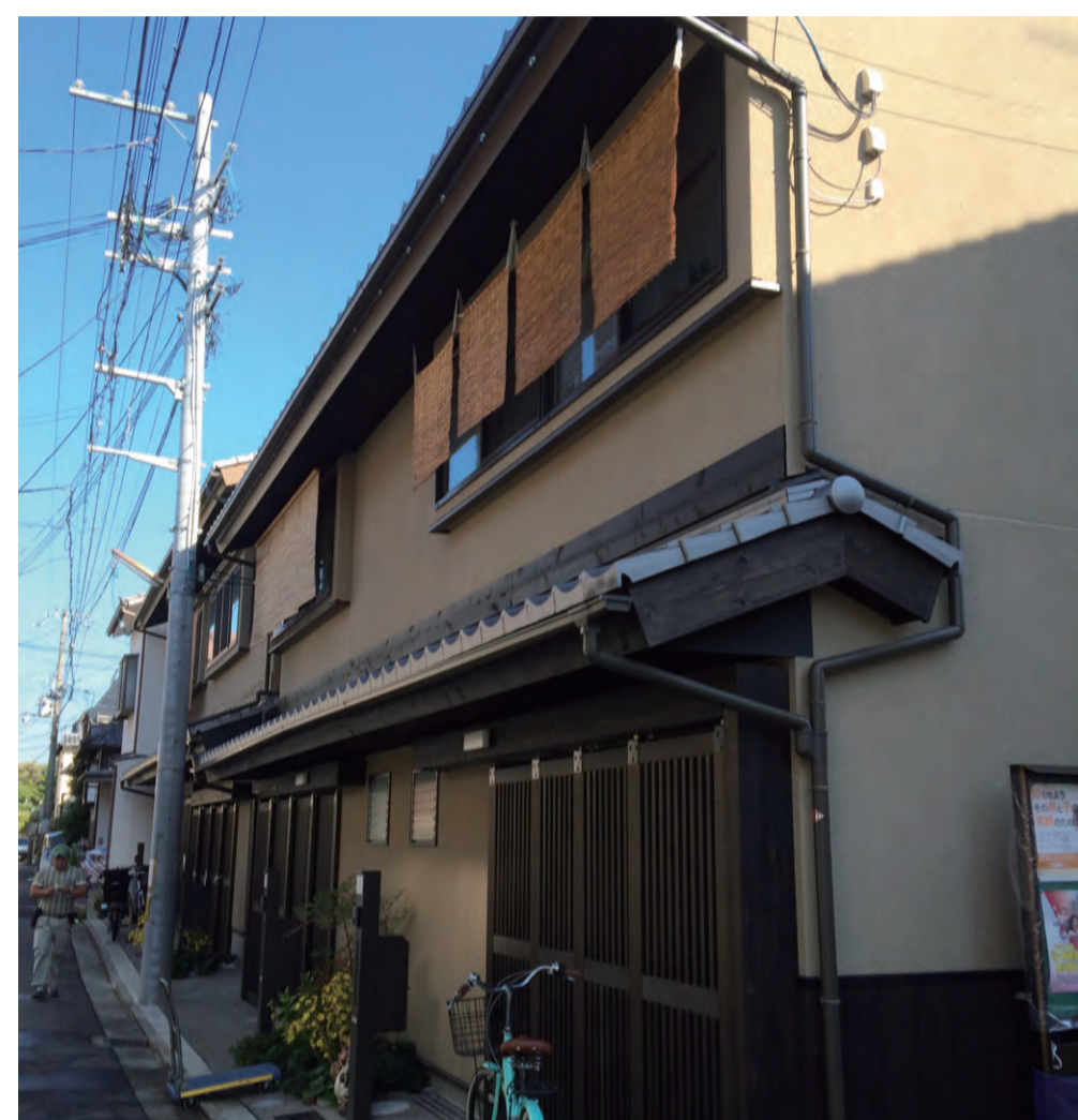
△B世帯外観参考イメージ。外壁・屋根がつながっているが、戸境間は柱をダブルとし、将来的な単独建て替えが可能な独立した構造とする。[平成の京町家東山八坂通]
